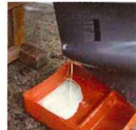
白濁したギヤオイル
